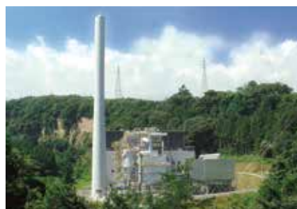
株式会社吾妻バイオパワー 吾妻木質バイオマス発電所
