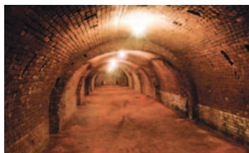
▲日本煉瓦製造 ホフマン輪窯
