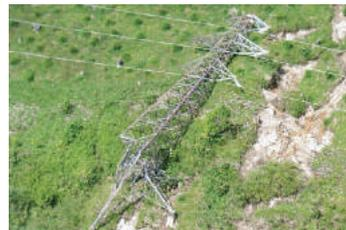
山の斜面の地崩れにより送電設備が倒壊
