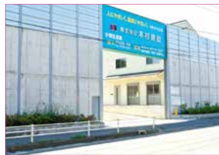
▲大和リサイクル工場入口付近 随所に近隣への配慮がうかがえる
