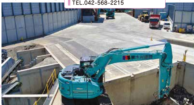
▼大和リサイクル工場
