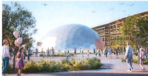
▲建物の外殻はさまざまな形の平面を組み合わせたボロノイ構造で、天候や時間帯などによって多様に見える方が変わるシルバーの膜は、未来に向けた多くの可能性を表現しています。
