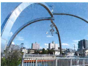
▲古利根公園橋
