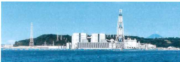
横須賀火力発電所（新1号機・新2号機ともに、汽力発電方式・石炭使用・65万kW出力）
