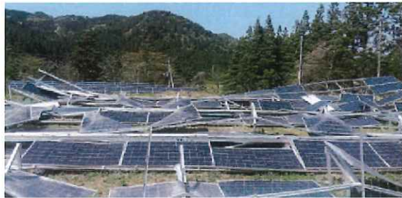
太陽光発電設備の倒壊：イメージ
