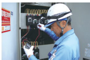
保護継電器の動作試験
