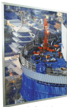
完成間近の▲ 東京スカイツリー (2012年完成)
