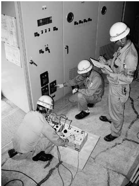
図 5-13 高圧受電設備における保護継電器の試験状況
